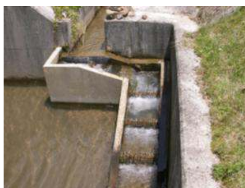
段差解消水路
