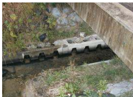
多孔コンクリート護岸
